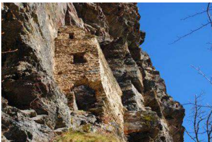
Slika 28. Ruševine srednjovjekovne građevine Kaštela (foto: www.fojnica.net)
